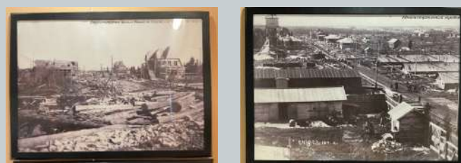
Рис. 4. Строительство Волховского пр., фотофиксация (фонд Музея истории города Волхова)
