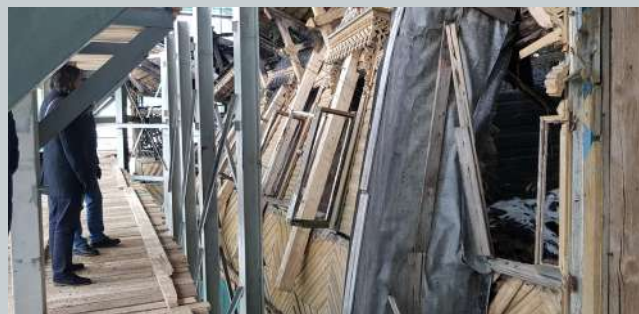
Рис. 4. Загородный дом Л. А. Змигродского, вывешивание стен второго этажа
