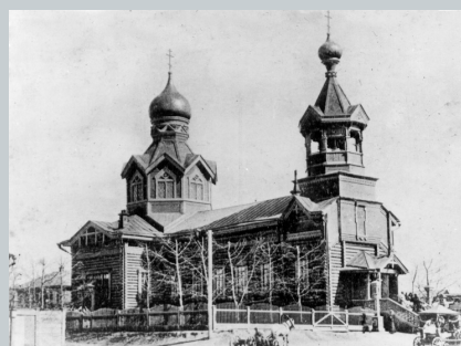
Рис. 3. Церковь св. пророка Даниила на ст. Обь
